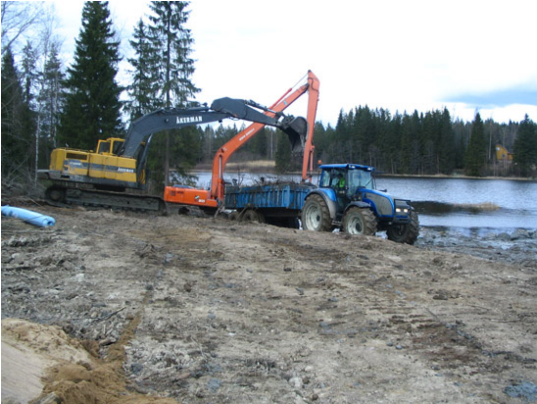
Ilman raskasta kalustoa Suutarinjärven kaltaiset työt eivät onnistu. Pitkäpuominen kaivaa, pienempi kaivuri avustaa lastauksessa ja poiskuljetettavan massan läjityksessä.
