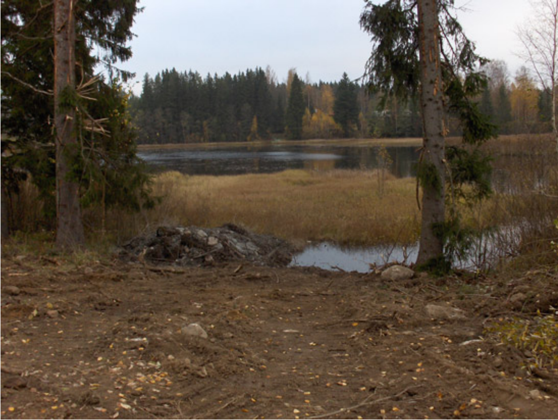
Ensimmäinen kuopaisu avattavan venevalkaman kohdalle on tehty.
