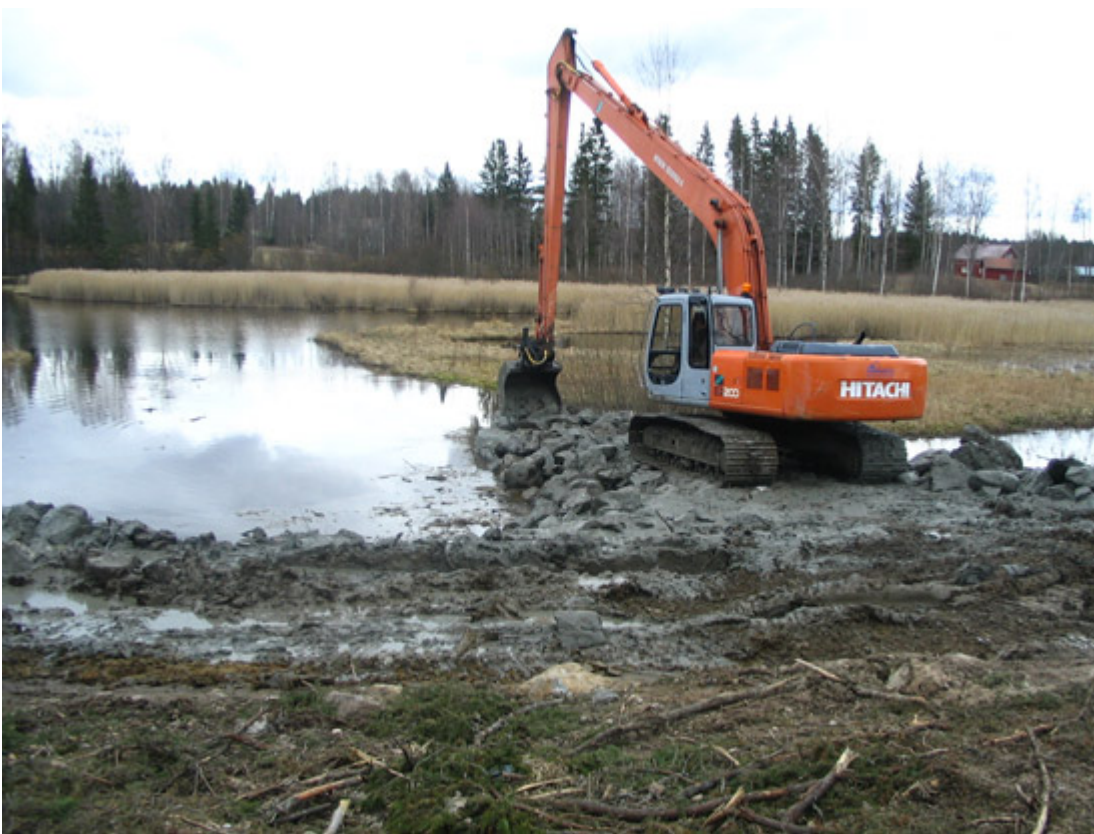
Ruoppaustyö on valmis, ja nyt syntyy valkama-aukon kylkeen vesityökaluston ajo- ja lastausramppi. Monilla järvillä kalustoa on vaikea saada veteen, kun ajoreittejä ei ole.
