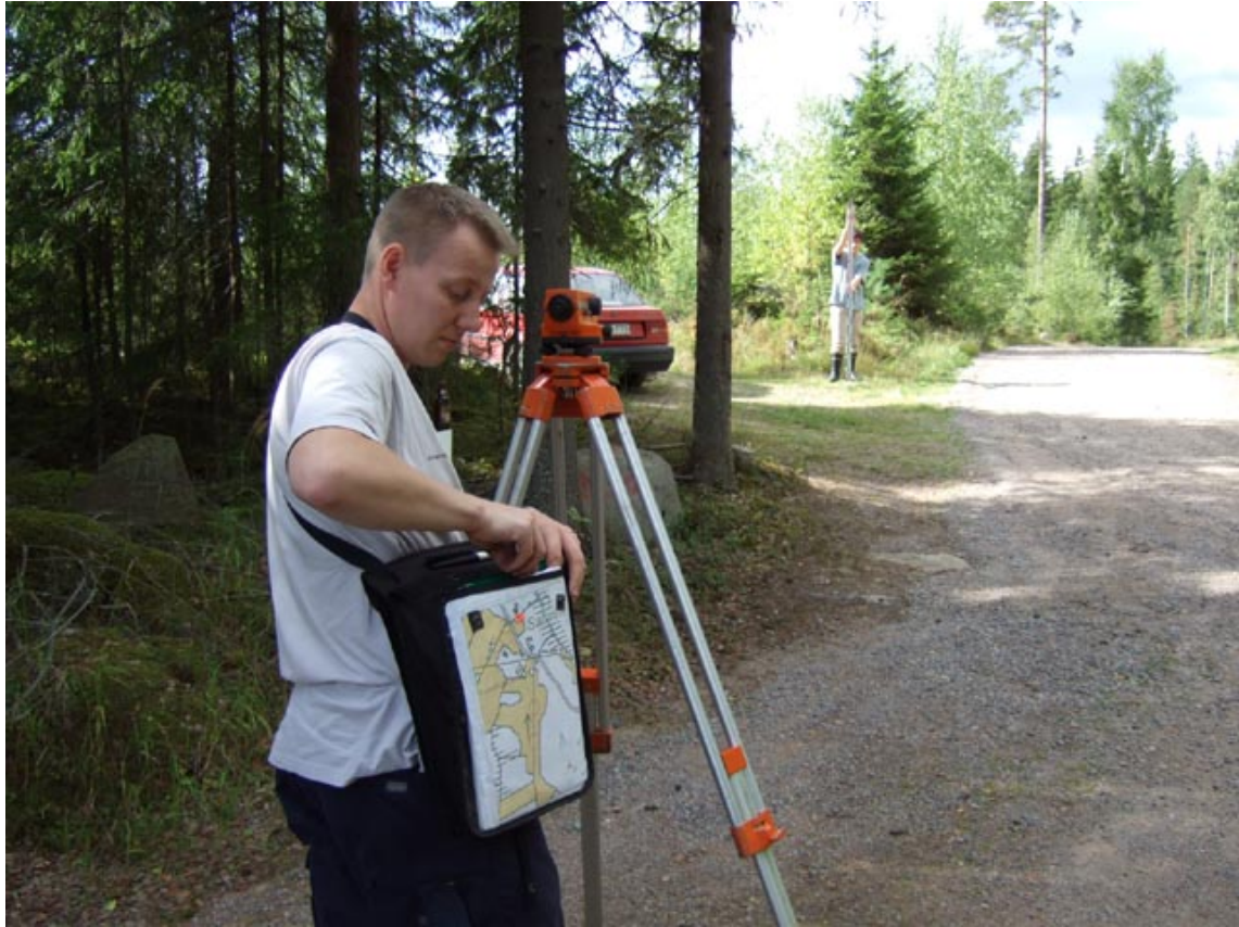
Ramboll Finland Oy:n Ville Yli-Teevahainen mittailemassa Valkiajärven yläpäässä korkeuseroja Kyrvönojan suunnitelmia varten avustajanaan Eero Klimoff (taustalla).
