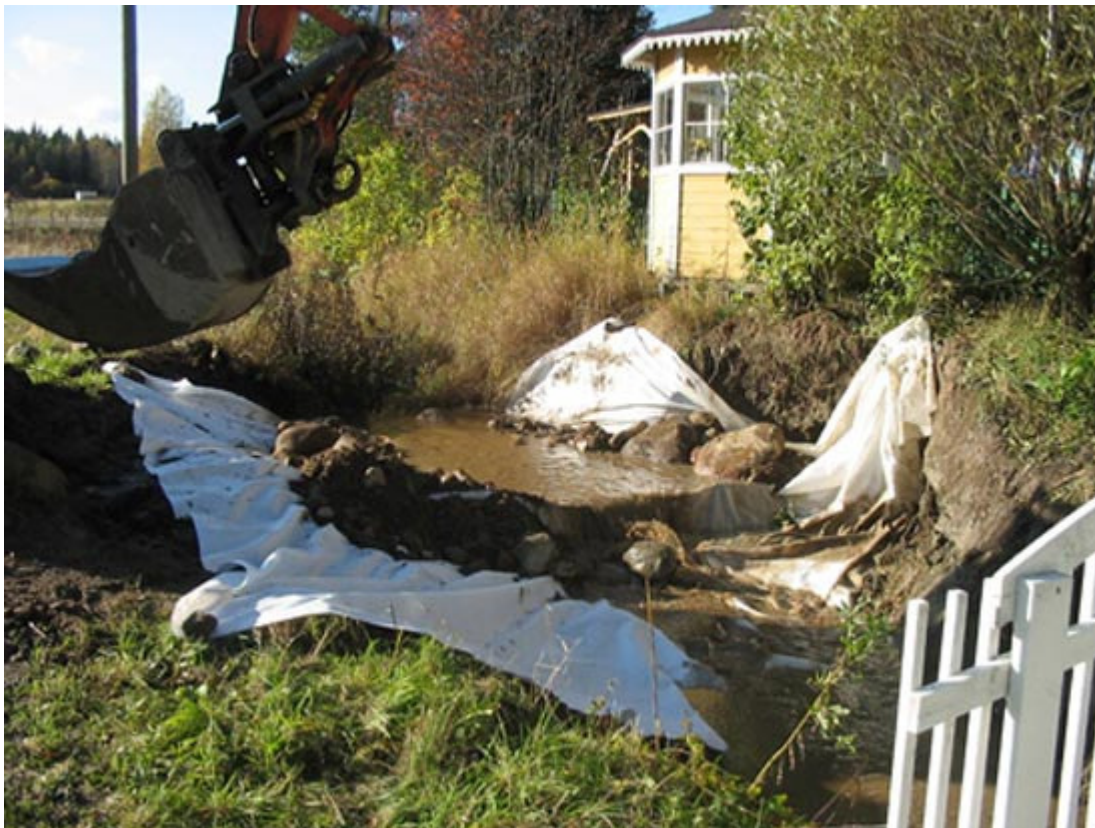
Sidekangas on asennettu paikoilleen, ja nyt aletaan kivittää varsinaista patorakennelmaa.
